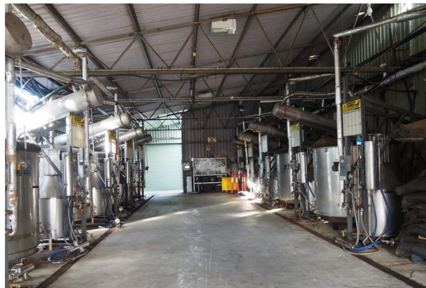
Destillationskessel der Destillerie in Albany, Australien, Mai 2025
